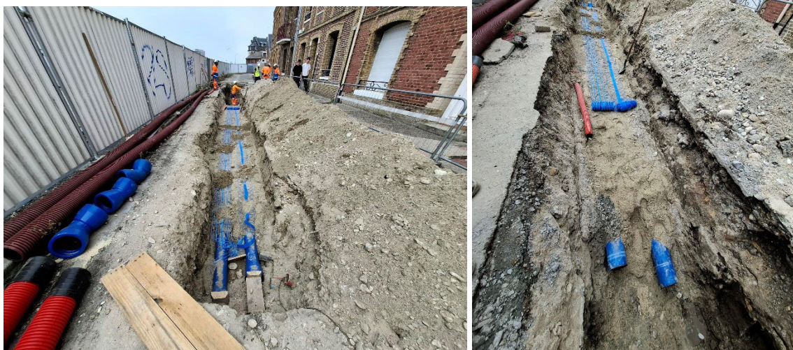
Travaux sur la canalisation du pont Colbert ©F. Thomas
